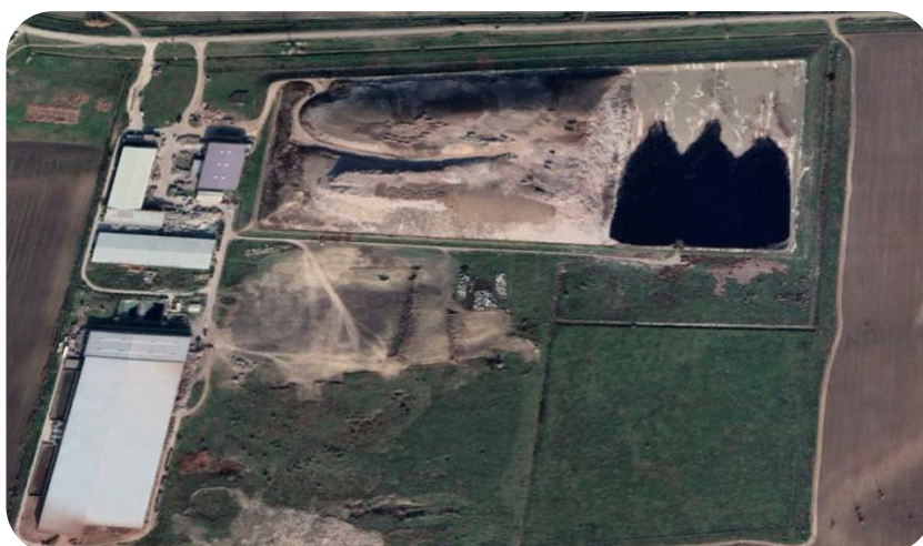
Figura 6-1 Depozitul de deșeuri municipale Țuțora
